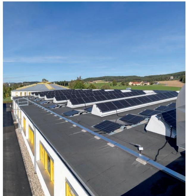
Gebäudedach nach Sanierung (isoliert mit Zusatz-PV)
